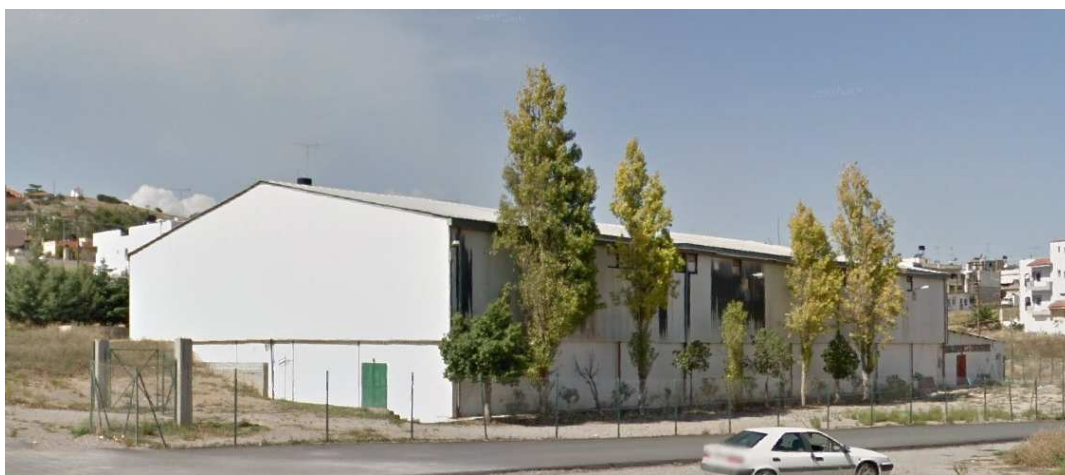
Εικόνα 1 Κλειστό Γυμναστήριο Καλαθοσφαίρισης Αρκαλοχωρίου.
